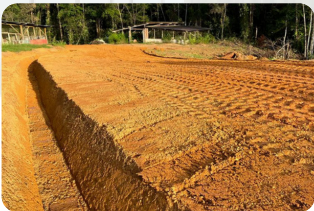
Création de chemin d'accès primaire et de canaux de drainage
